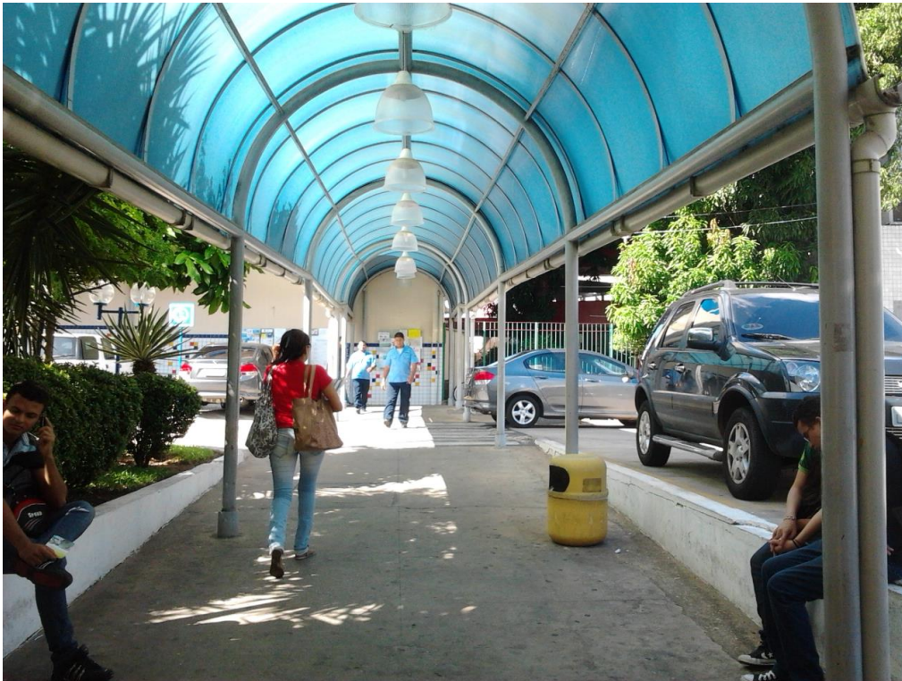
Fotografia 3 – Prédio “B” e “C” – passarela e rampas
